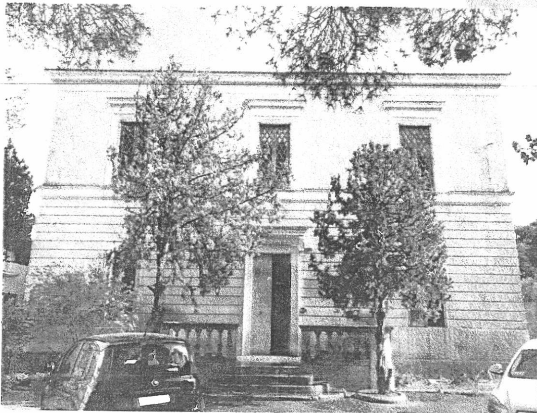
Foto n.1 Vista d'insieme del fronte principale del corpo di fabbrica
